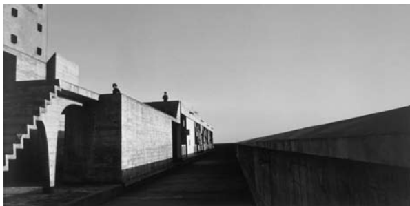
Toit terrasse de l'Unité d'Habitation, Rezé
